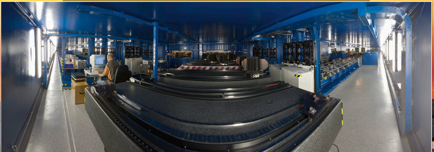
Panoramische blik op de tunnel van de Very Large Telescope Interferometer.
